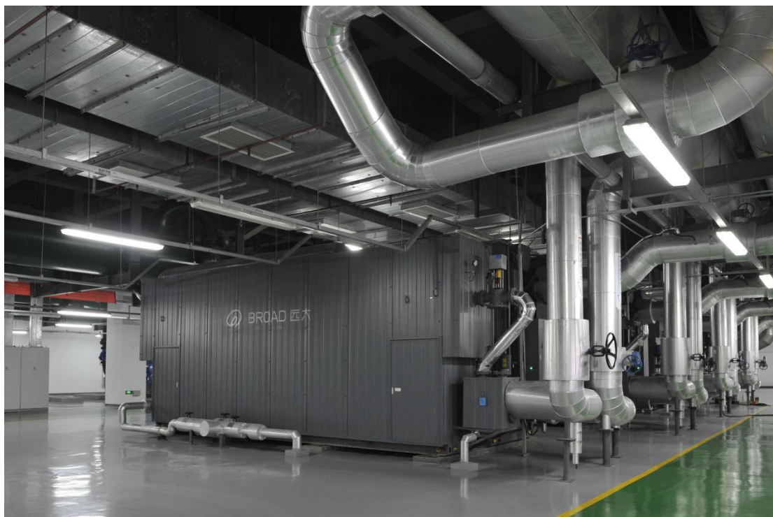
图 44 苏州独墅湖创新区月亮湾集中供热供冷中心项目
