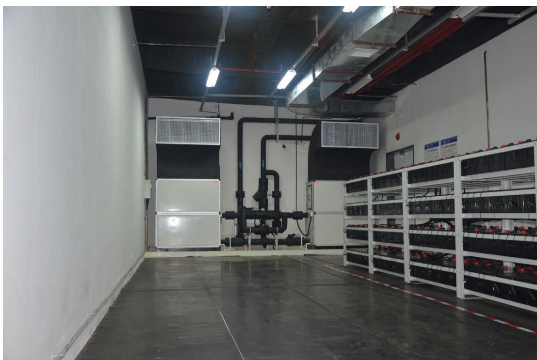
图 48 高新翼云能耗监控主机及配电柜
