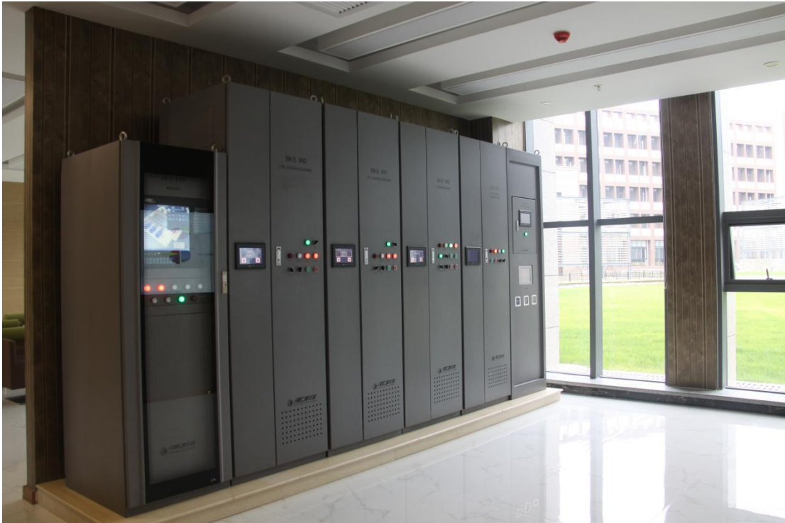
图 49 贵州汇通华城科技空调节能机组
